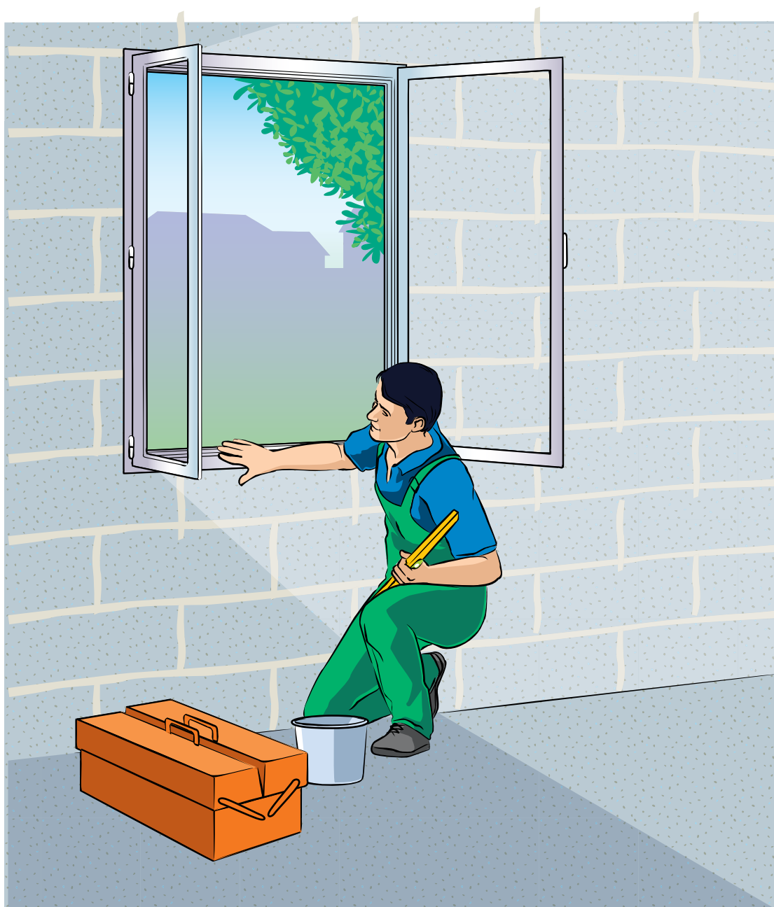
▲ Figure 84 : Vérification finale de la fenêtre
