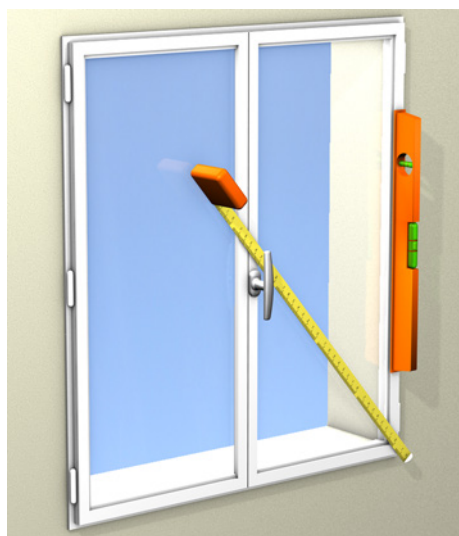
▲ Figure 25 : Vérification de l'aplomb de la fenêtre
